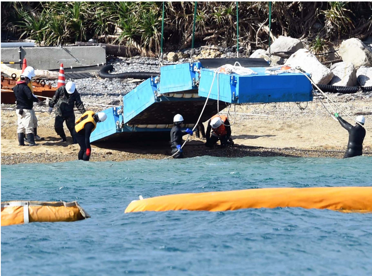
海上作業に向けて浮棧橋再設置の準備作業を進める作業員ら15日前、名護市辺野古沿岸部
